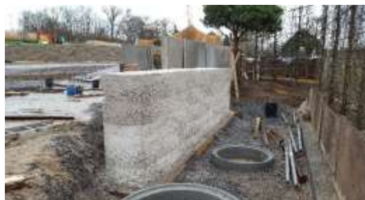
Stampfbeton mit Weißzement Landesgartenschau Öhringen 2016
