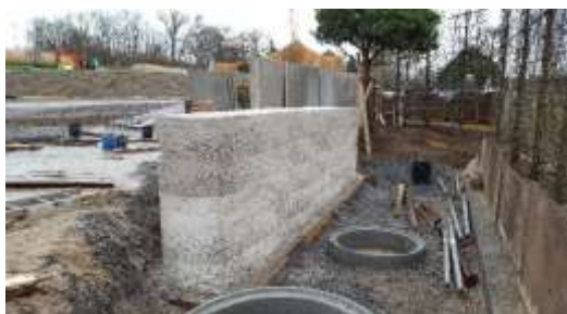
Stampfbeton mit Weißzement Landesgartenschau Öhringen 2016
